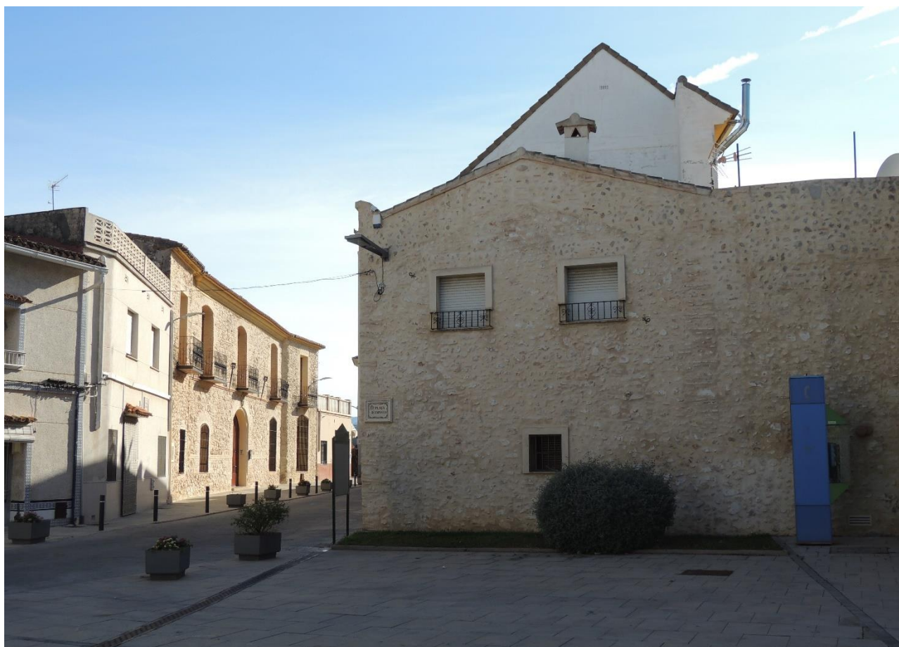
Vista de la fachada sur de la Plaza de España y la Calle del Horno, a la izquierda (con la Casa Gran) con edificio reciente de excesiva altura y cubierta muy inclinada, sobresaliendo por encima de un espacio que se ha intentado recuperar en los últimos años. Fuente: AUG-ARQUITECTOS SLP
