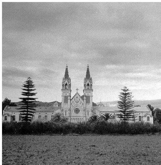
Vistas del edificio del convento de Esclavas el primer cuarto del siglo XX. Fuente: Archivo Mañas.
